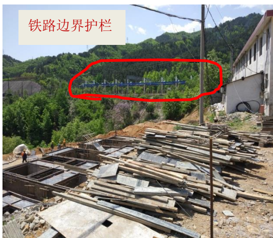
项目场内建设情况
