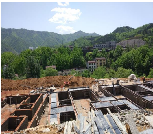
项目场内建设情况
