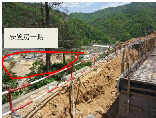
项目北侧边界（护坡）
