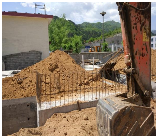
项目场内建设情况
